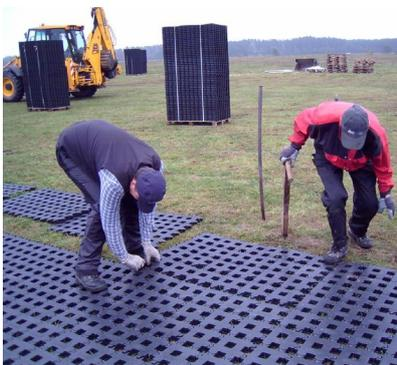
Teilstücke werden auf dem Boden ausgelegt und positioniert
