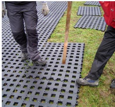
PERFO-Matten werden mittels Fußdruck verbunden
